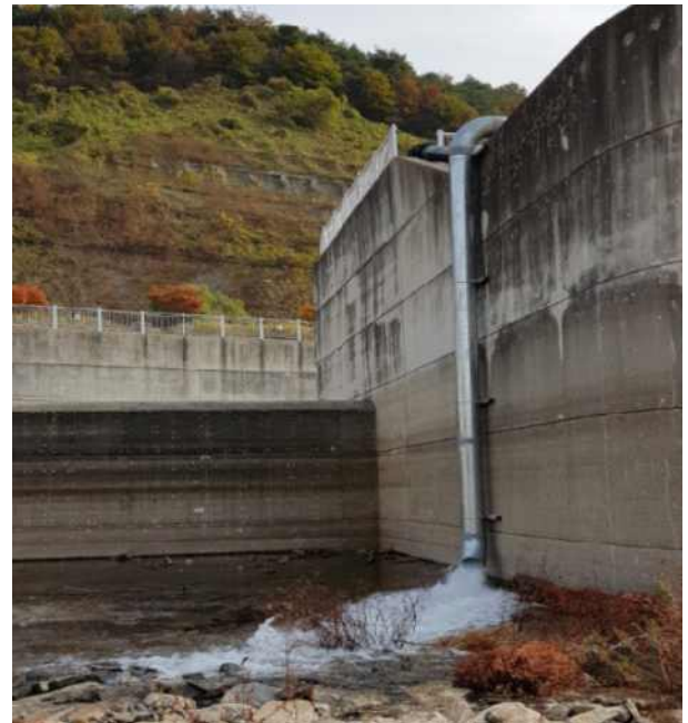
<평림호내 여수로 안쪽 방류전경>
